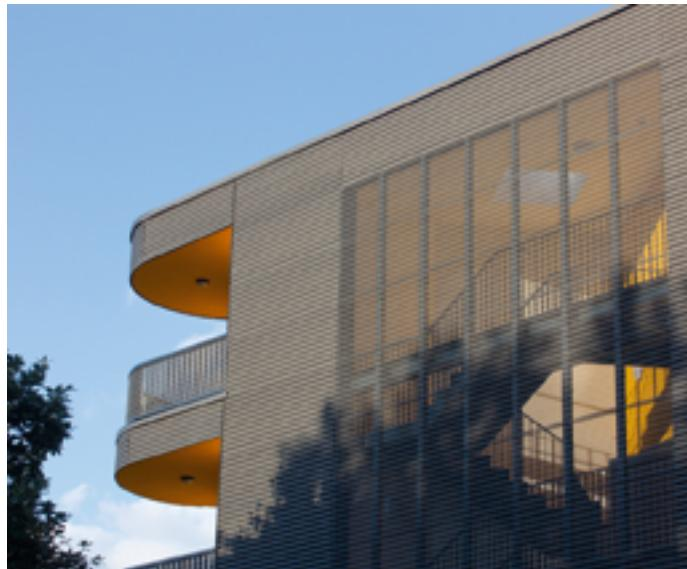
Perforierte Elemente eignen sich als Sonnenschutz. Gebäude und Nutzer können so vor Blendeffekten, Reflexionen und Überhitzung durch starke Sonneneinstrahlung geschützt werden. Gleichzeitig kann man aber auch einen hohen Grad an Transparenz und Sichtverbindung nach außen erhalten. Die gestalterischen Möglichkeiten der Elemente sind vielseitig und individuell machbar.
